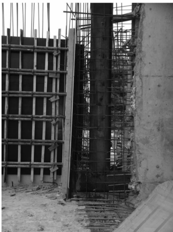
图 3 地下室剪力墙后浇带位置图
